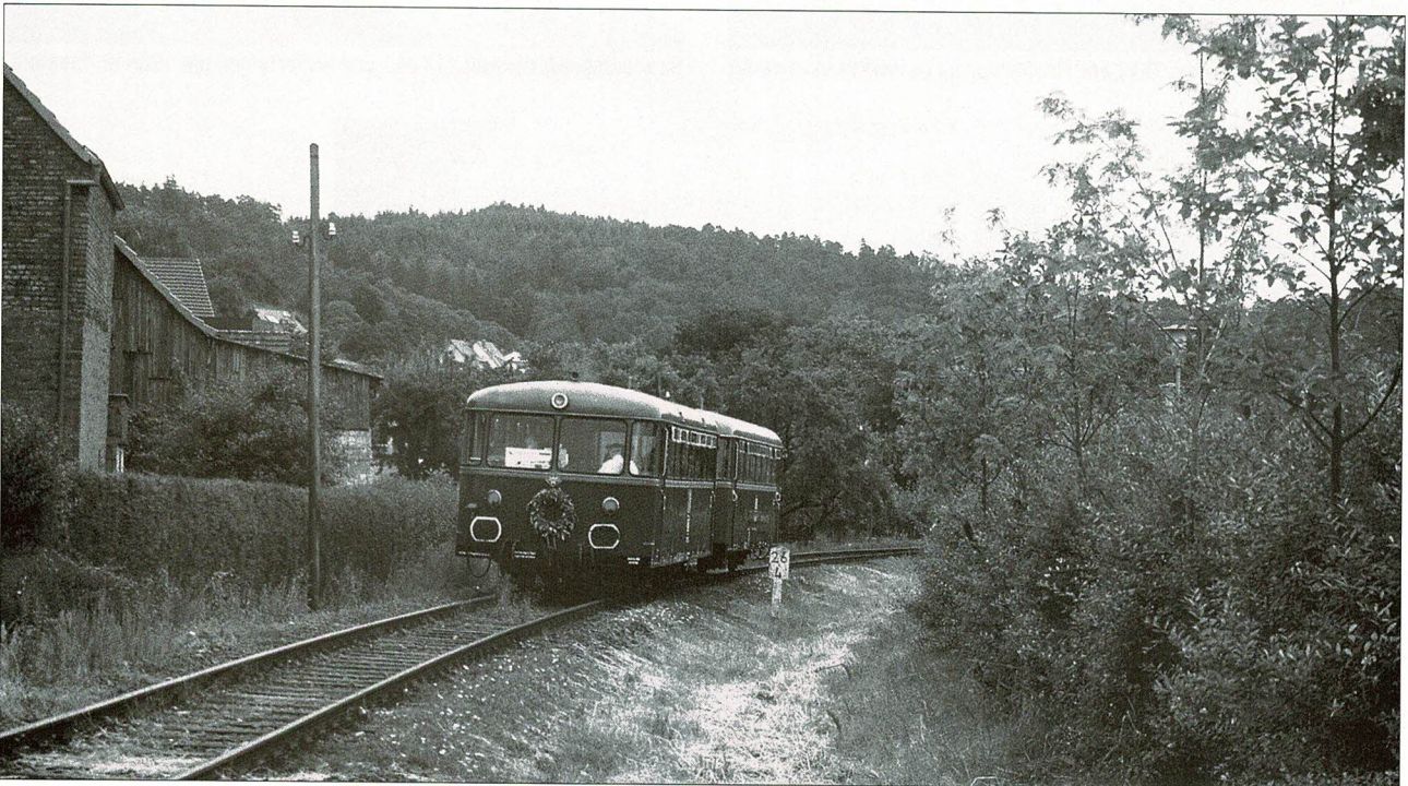
Der Sonderzug verlässt am 19. Juni 1999 den Bahnhof Sandbach in Richtung Neustadt (Odenwald). Der Oberbau macht einen maroden Eindruck
